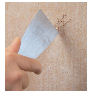
Kratzprobe Prüfen der Oberflächenfestigkeit
